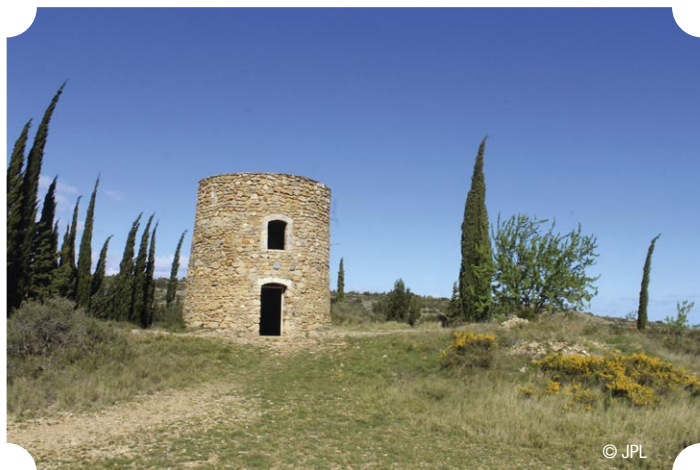
Les vestiges d'un moulin à vent face à la plaine du Roussillon.
